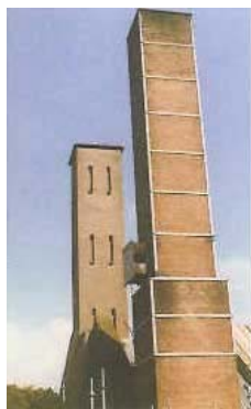
In het ontwerp van Schmidt kregen de schoorstenen niskasten, die mooi aansluiten bij het motief van de rest van het gebouw
