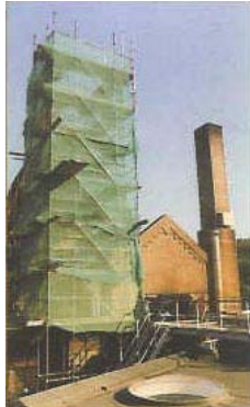
Renovatie van de schoorstenen van het crematorium Driehuis-Westerveld, een rijksmonument
