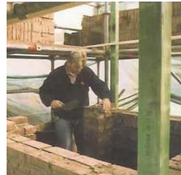
In totaal zijn er zo'n 22.000 stenen in de schoorsteen verwerkt
